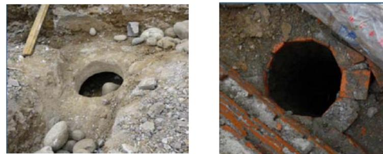
一般都应清除异常，进行回填，回填材料有小圆石、干净的土、水泥拌合土等，夯填时必须分层。若特别深、宽的，一般不建议采用回填处理，而应咨询专业工程师现场勘查后，听取其意见。
