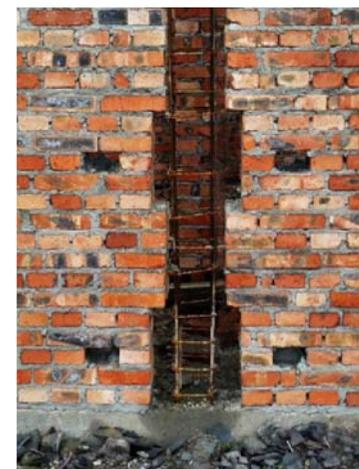
拉结筋应 $\geq 2\phi 6@500$ ，伸入墙体至少1米
