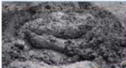
第三步：水量应适宜，搅拌完成后，混凝土应在90分钟内用完。
