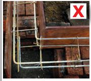
转角无锚固。 The corner lacks any anchor.
