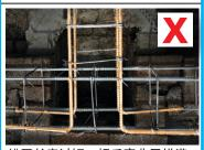
锚固长度过短。相反弯曲同样满 足规范要求,但建议用相对弯曲 更安全,如上图。
